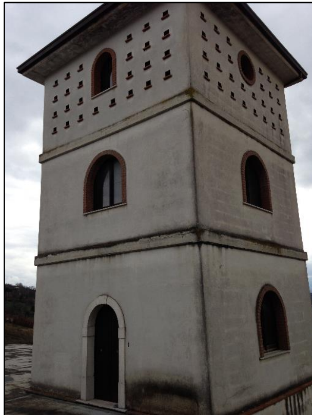
Figura 7: La moderna torre rinascimentale
