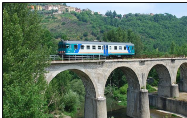
Figura 41: Attraversamento sul ponte dopo la stazione di Luogosano
