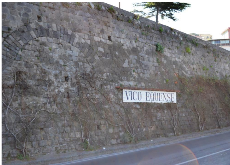
Figura 223: Muro in tufo grigio a Vico Equense
