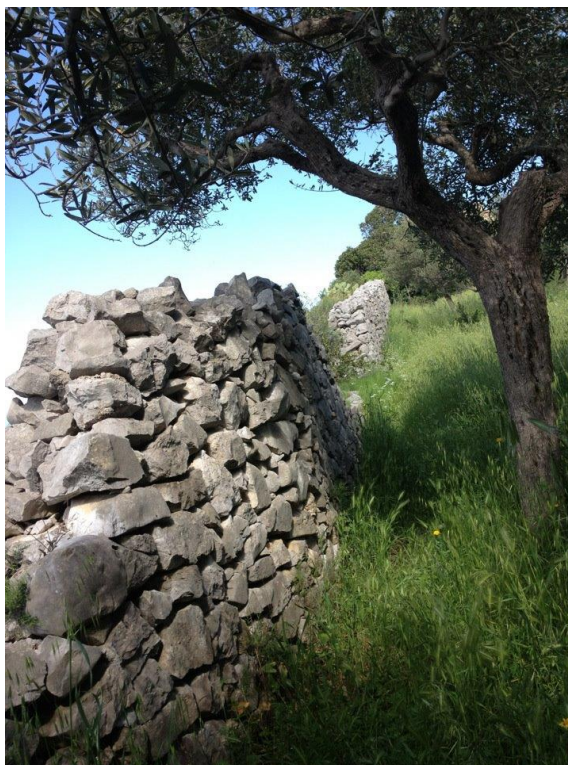
Figura 224 -Costruzioni in pietra: Murature a secco ai Casini
